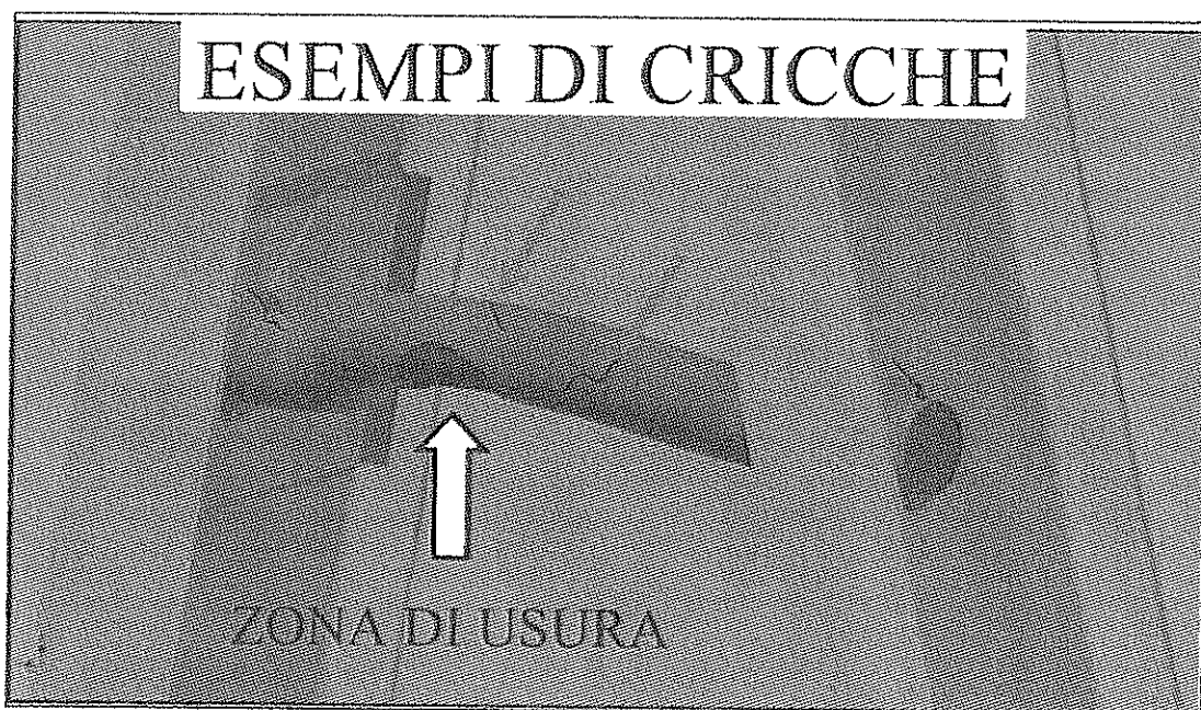
Figura 45. Esempi di cricche e usura del materiale del gancio di incarramento.
